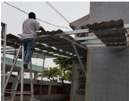
照片四：搭建機車停車棚。施工中(左圖)、完工後(右圖)
