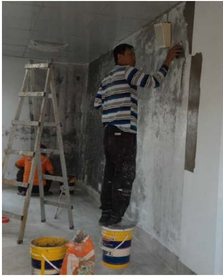
照片六：辦公室壁癌整治。施工中(左圖)、完工後(右圖)
