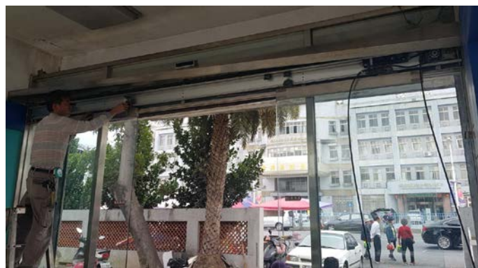
照片八：修復入口玻璃門可正常運作
