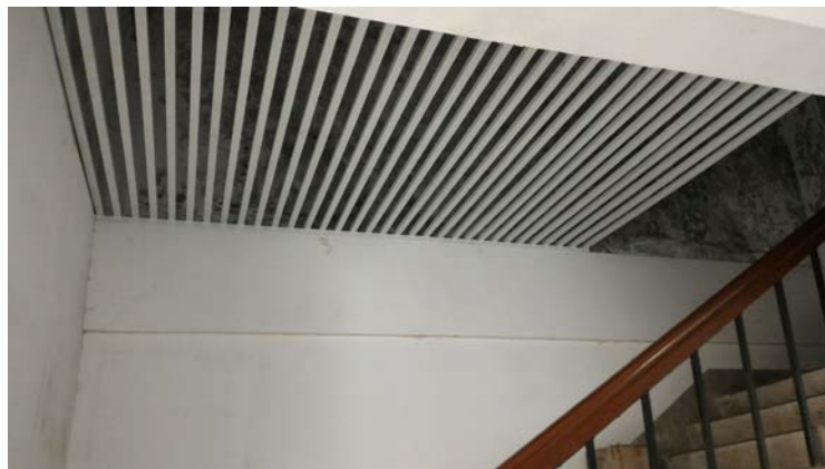
照片七：樓梯美化工程
